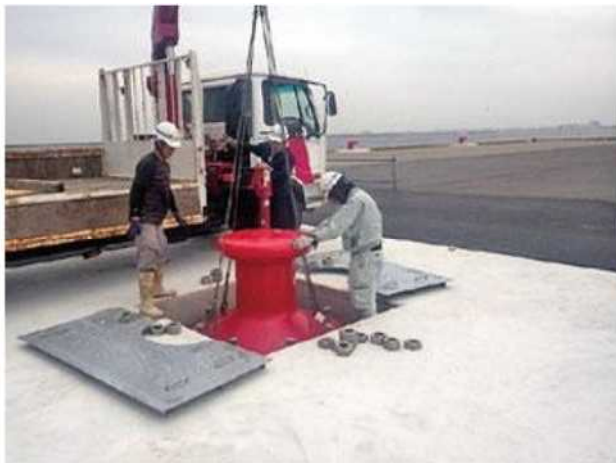
図 2-1-46 係船直柱を据え付ける様子
