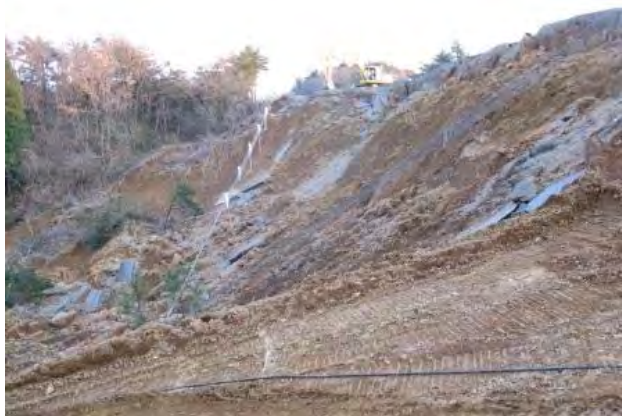
図4 能登有料道路別所岳PA南東の斜面崩壊（谷頭部の盛土部分が崩壊した）
