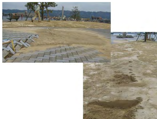
図 7 七尾マリンパークでの噴砂（護岸の内側が沈下し護岸と埋立層の境界から液状化した砂と地下水が噴出した。）
