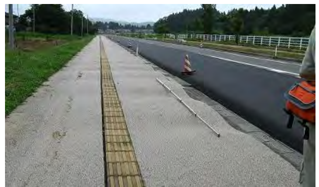
図10 柏崎市堀付近の県道73号線の波長2m程度の波状変形(北緯37度19分56秒、東経138度34分55秒)
