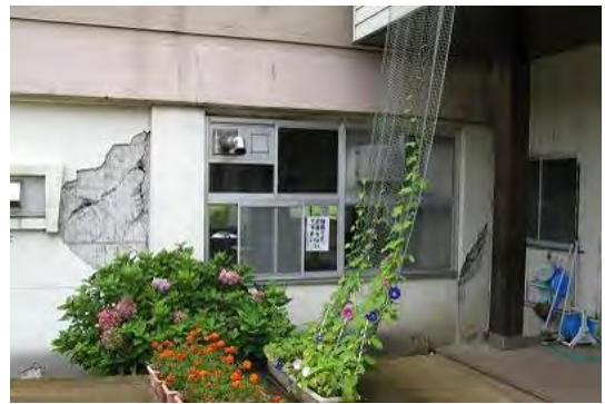
図8 長岡市小国町七日町の下小国小学校における鉄筋コンクリート製柱・壁の破断(北緯37度19分27秒、東経138度43分1秒付近)
