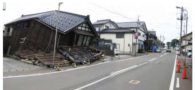
図9 柏崎市新橋での木造家屋の倒壊(北緯37度22分1秒、東経138度32分58秒付近)
