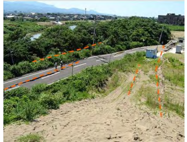
図6 柏崎市山本付近に発生した地滑り（北緯 37 度 23 分 38 秒，東経 138 度 35 分 5 秒付近，点線は亀裂の位置。）
