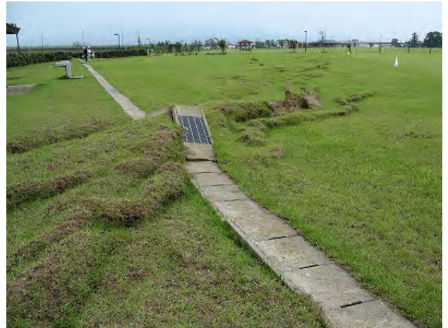
図7 柏崎市橋場町鯖石川改修記念公園での液状化－流動化に伴う地表の変形（北緯 37 度 23 分 29 秒，東経 138 度 34 分 38 秒付近）
