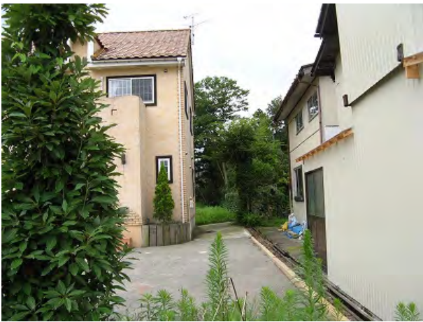
図4 柏崎市長崎（北緯 37 度 23 分 58 秒，東経 138 度 36 分 1 秒付近，沼の北の砂丘最下部では液状化－流動化による構造物被害が多く見られた。ここでは，建物の重みで地中に沈降している。）
