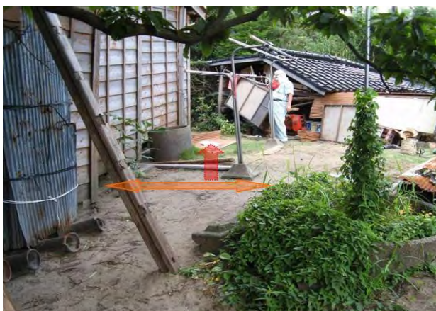
図 3 図 1 の Ph3 地点の写真（隆起に伴い手前の家屋は傾き，奥の小屋は倒壊した。）
