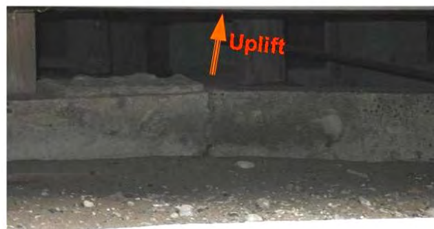
図 5 図 1 の Ph5 地点の写真（家屋の左側の土台の下が隆起し，家全体が右へ動いて歪み，戸が閉まらなくなった。）
