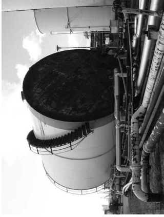
写真8 転倒した劇物のタンク（地震時は空）
