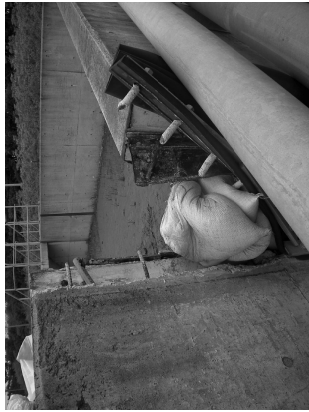
写真 37 防油堤の破断状況（ゴムシートが破断し、大きく開口。）
