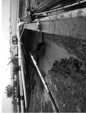
写真2 防油堤直下の基礎の洗掘
