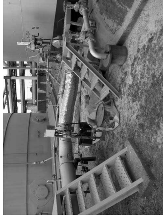
写真 32 タンク付近が液状化、タンクが沈下
