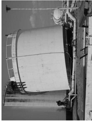
写真7 津波により浮上・移動したタンク（容量2千kl、地震時は空）
