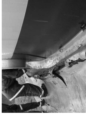
写真 33 タンク沈下、基礎の変形
