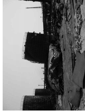
写真 20 倒壊したアスファルトtank
