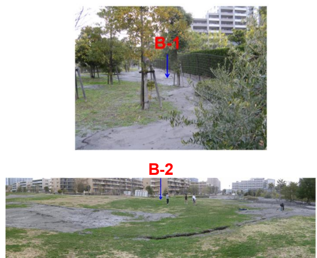
図 2 ボーリング地点付近の状況。B-1 は太平洋沖地震後に多量の砂と地下水が噴出し地表が大きく波打った場所、B-2 は噴砂や噴水が無く地表の変形もなかった場所。
